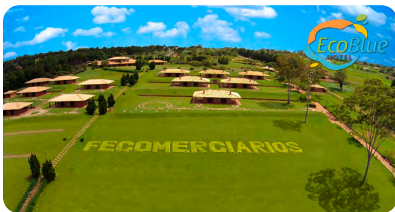
Centro de Lazer em Avaré.
